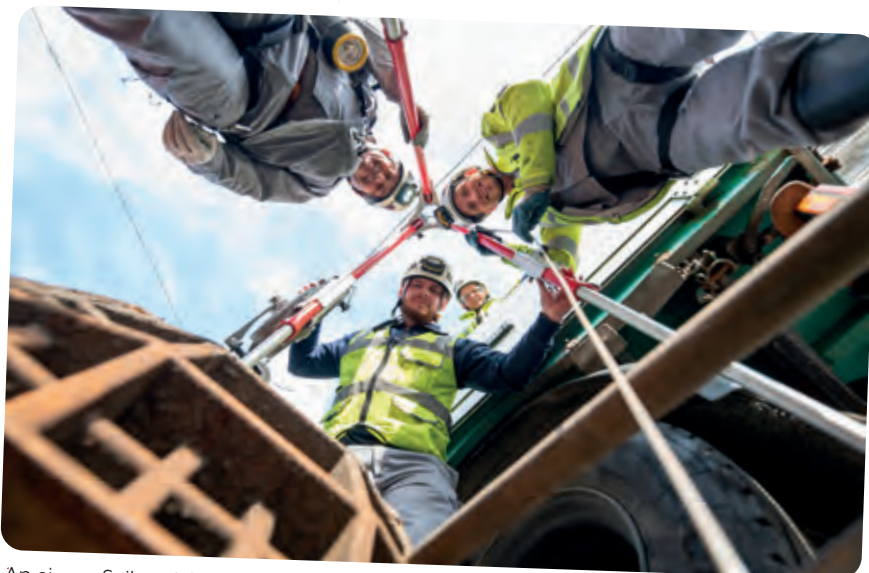
An einem Seil gesichert geht es fünf Meter tief in das Kanalsystem.
