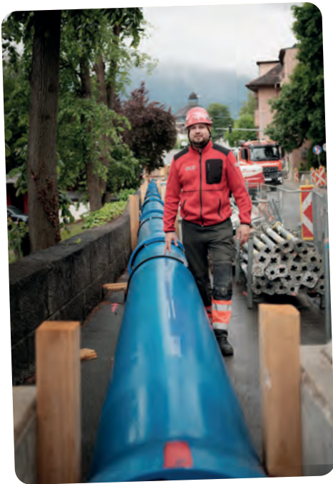
Marko betreut den Umbau der Transportleitung.
