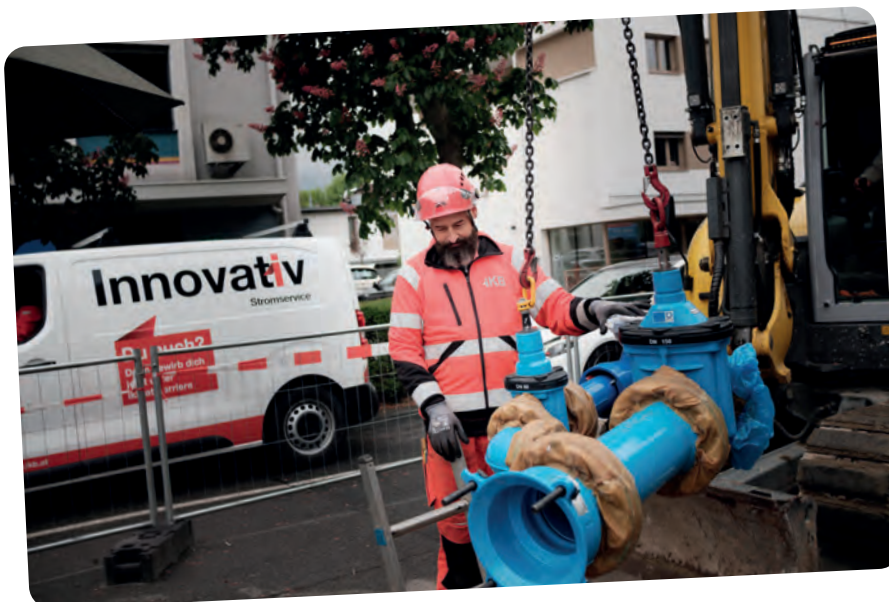
Stjepan bringt das neue Versorgungsleitungsrohr in den Schacht.
