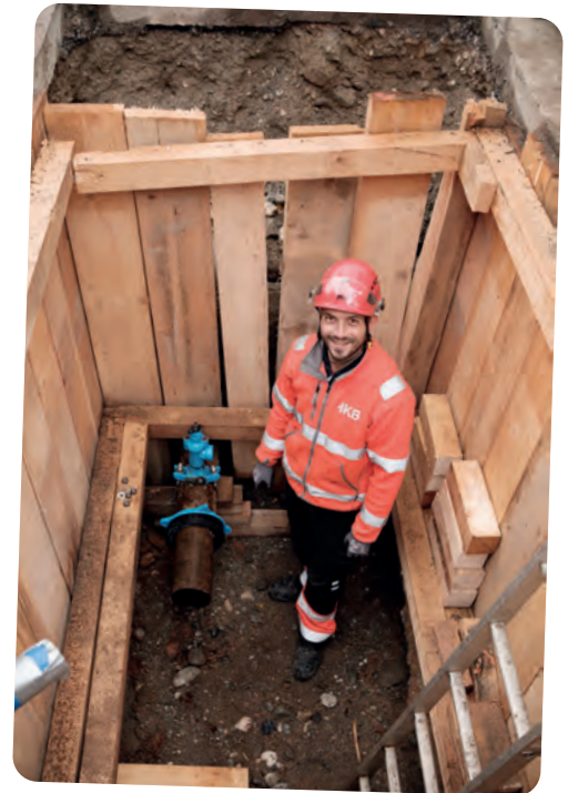
Florian wartet auf das Versorgungsleitungsrohr.
