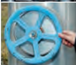
Günter Landerl mit ELG-Mitarbeiter Eduard Stacherl auf Inspektionstour. Die Rohre am Behälter dienen dem Brandschutz. Es kann geschäumt, aber auch gekühlt werden. Die vielen Ventile können nur mit der Hand bedient werden. Eine Steuerung über das Internet wäre zu gefährlich.
