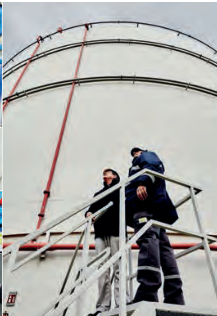
Günter Landerl mit ELG-Mitarbeiter Eduard Stacherl auf Inspektionstour. Die Rohre am Behälter dienen dem Brandschutz. Es kann geschäumt, aber auch gekühlt werden. Die vielen Ventile können nur mit der Hand bedient werden. Eine Steuerung über das Internet wäre zu gefährlich.
